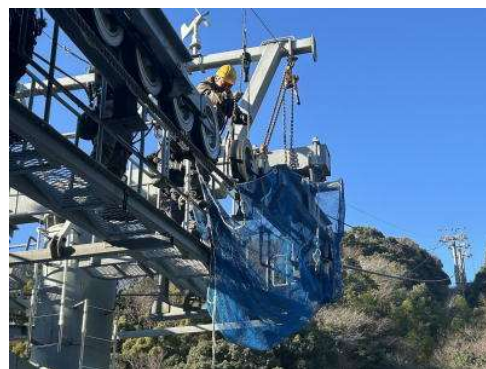
支柱索輪整備
